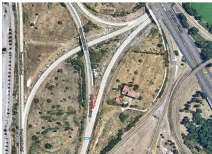
1. Vista aerea del G-light (indicato con tratto rosso)
